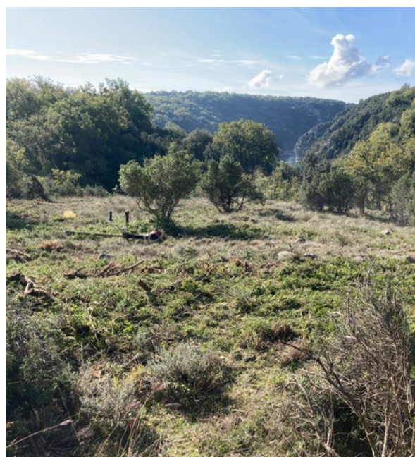
Travaux d'OLD en cours (7)
